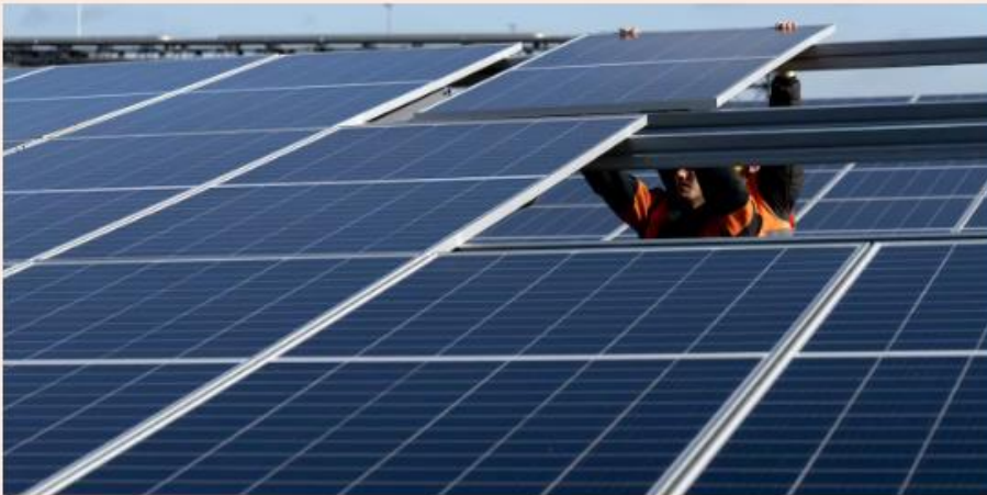
Aanleg van een zonnepark op een industrieterrein in Groningen. Het stroomnet zit vol, 6600 bedrijven staan op een wachtlijst voor een aansluiting. Foto: Sander Koning/ANP
