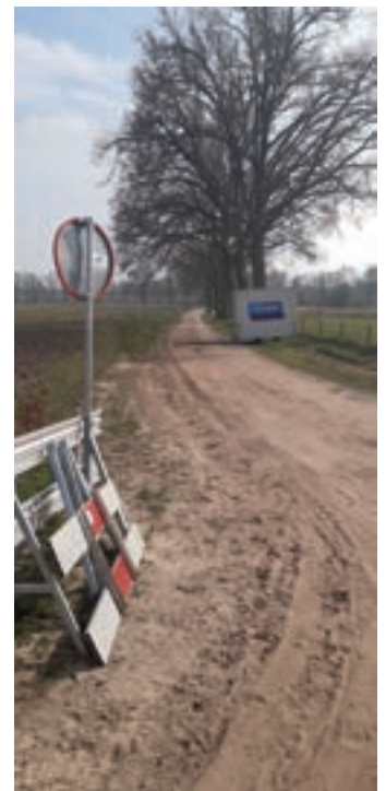
▲ Op dit moment wordt overal in het land gewerkt aan de uitbreiding van lokale netwerken, maar het tekort aan vaklieden zorgt ervoor dat aanvullende maatregelen gewenst zijn.
