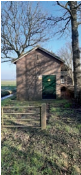
▲ Transformatorhuisjes worden in hoog tempo geschikt gemaakt als schakel in een toekomstbestendig energiesysteem.
